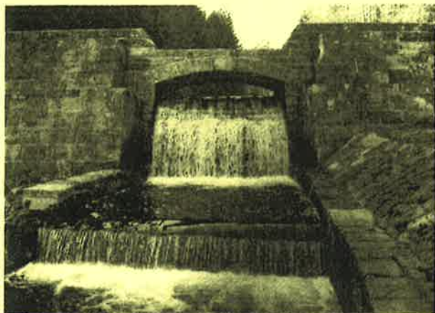
Die beiden Regenrückhaltebecken der Gemeinde im Holzwald wurden auf Staatskosten saniert und erfüllen nun wieder für viele Jahre ihren vorgesehenen Zweck.
